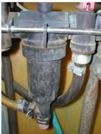
tlačni filter, samodejno čistilni tlačni filter
